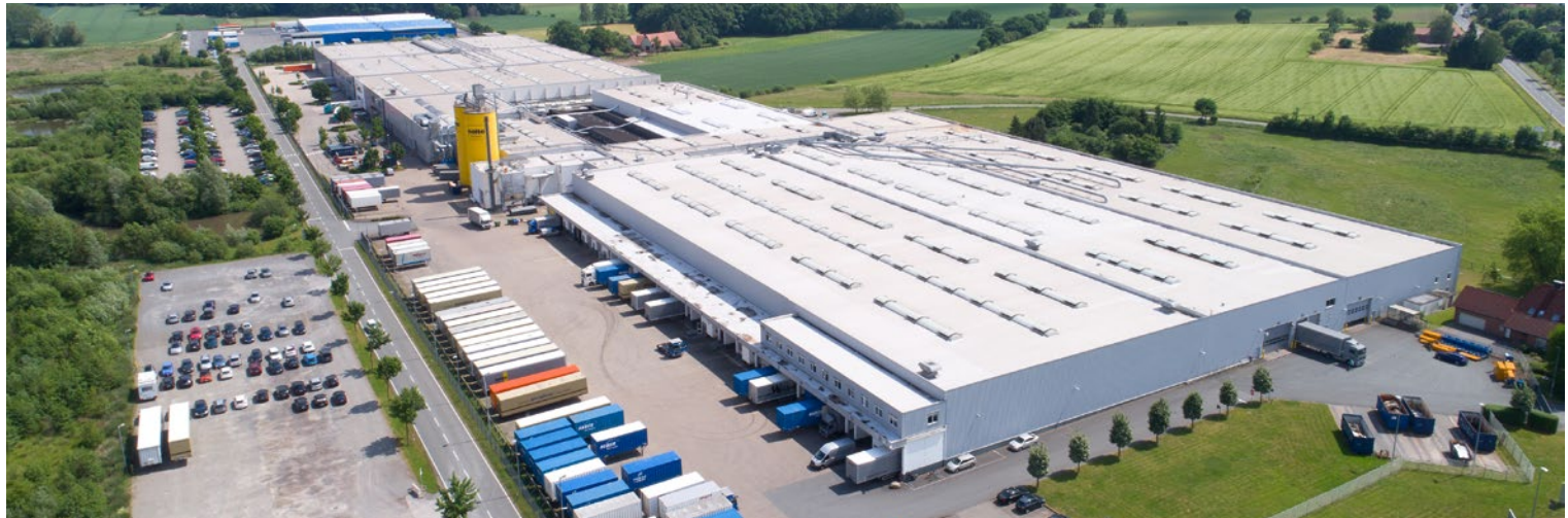
Site Nolte Küchen à Melle, Basse-Saxe
