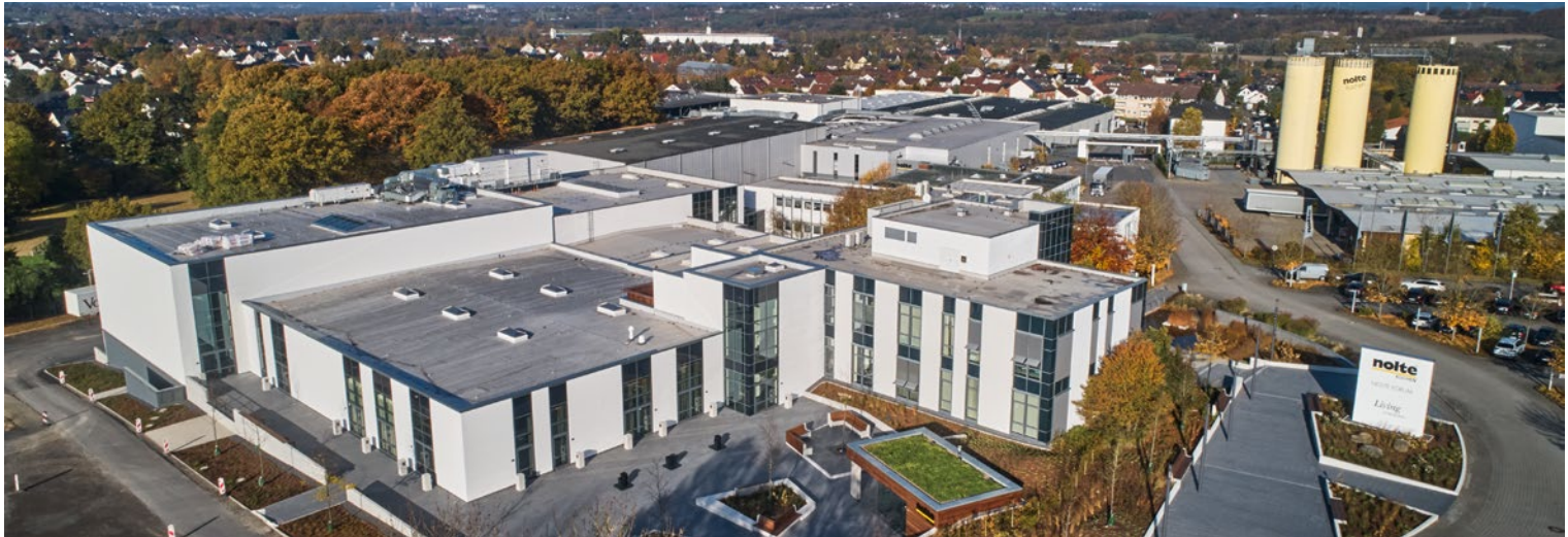
Site de Nolte Küchen à Löhne (Rhénanie-du-Nord-Westphalie)
